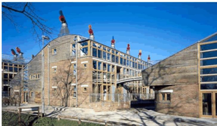
Les bâtiments comprennent une **isolation thermique passive** très importante, complétée par une centrale de co-génération fonctionnant au bois issu d'élagages récupéré dans les environs, et de panneaux photovoltaïques. On réduit ainsi de 90% les besoins de chauffage et de 60% la consommation d'électricité tirée sur le réseau de la ville.
